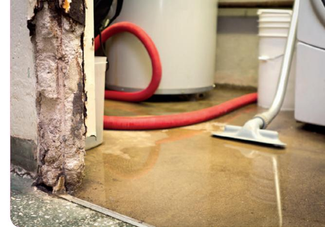
Regenwasser gehört nicht in den Schmutzwasserkanal, denn dort füllt es die Leitungen. Deswegen wird dieses Regenwasser auch als Fremdwasser bezeichnet. Dieses Fremdwasser belastet unsere Kläranlagen und die Kosten für die unnötige Spezialbehandlung gehen zu Lasten der Allgemeinheit. Das Fremdwasser verschärft zudem die oben beschriebene Hochwasserproblematik: In Gebäuden mit fehlender Rückstausicherung kann es zu nassen Kellern und so zu Ärger in der Nachbarschaft führen.
